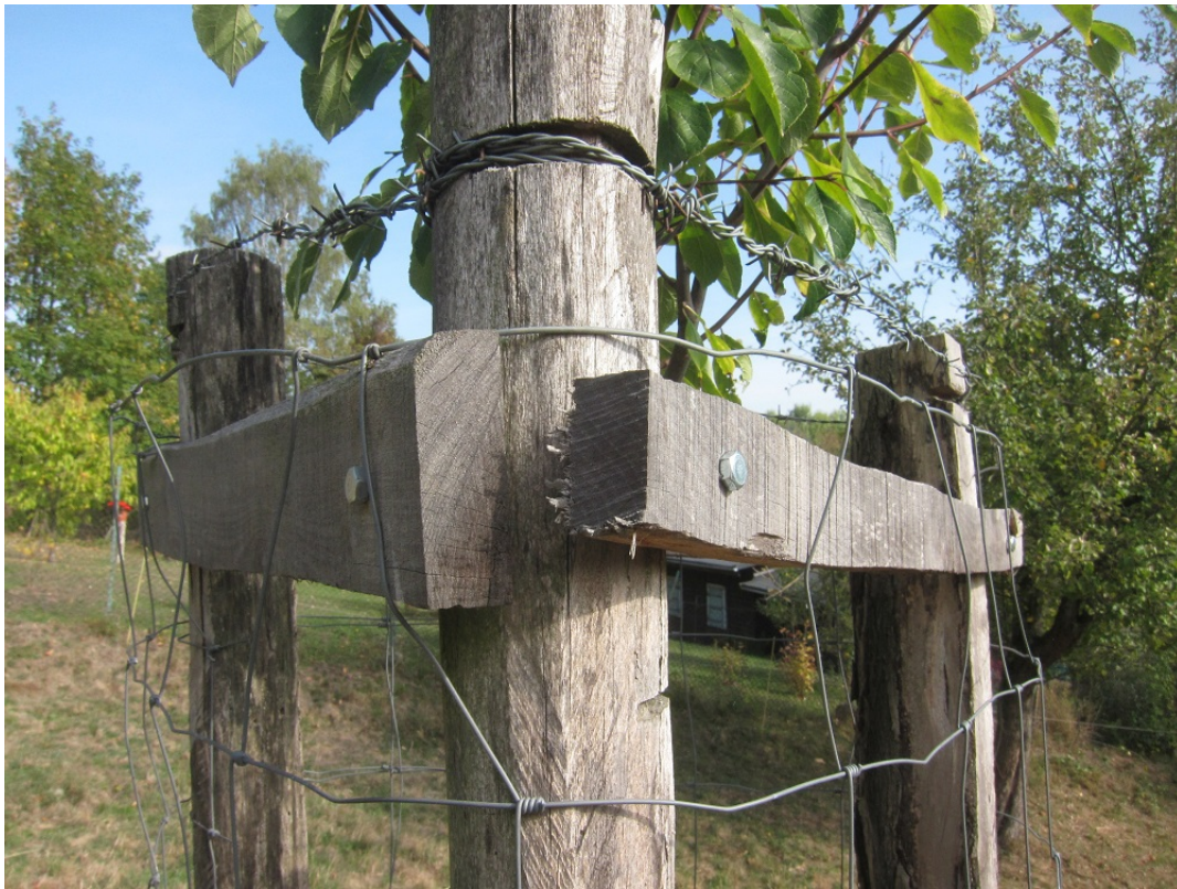
Abbildung 6: Verschraubung bei Hartholz auch ohne Unterlegscheiben
