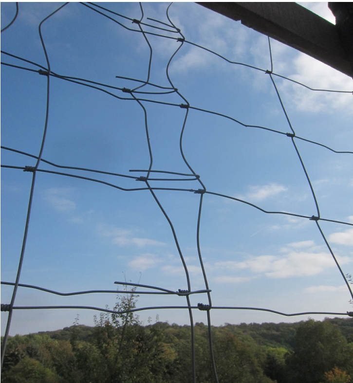
Abbildung 8: Verflechtung des Knotengeflechtes
