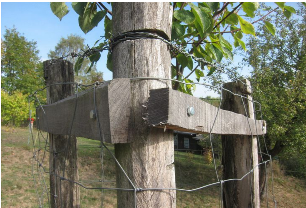
Abb.7: Verschraubung bei Querlatten aus Hartholz auch ohne Unterlegscheiben.
