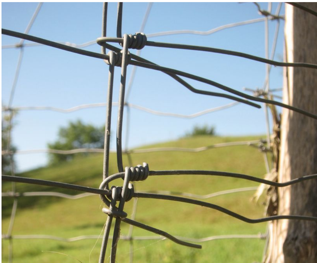
Abb.16: beim abschneiden lang gelassene Enden ermöglichen lange Hebel beim hineinbiegen (Bsp. oben) und ein stabilisierend wirkendes verrödeln (Bsp. unten) beim schließen der Einhausung
